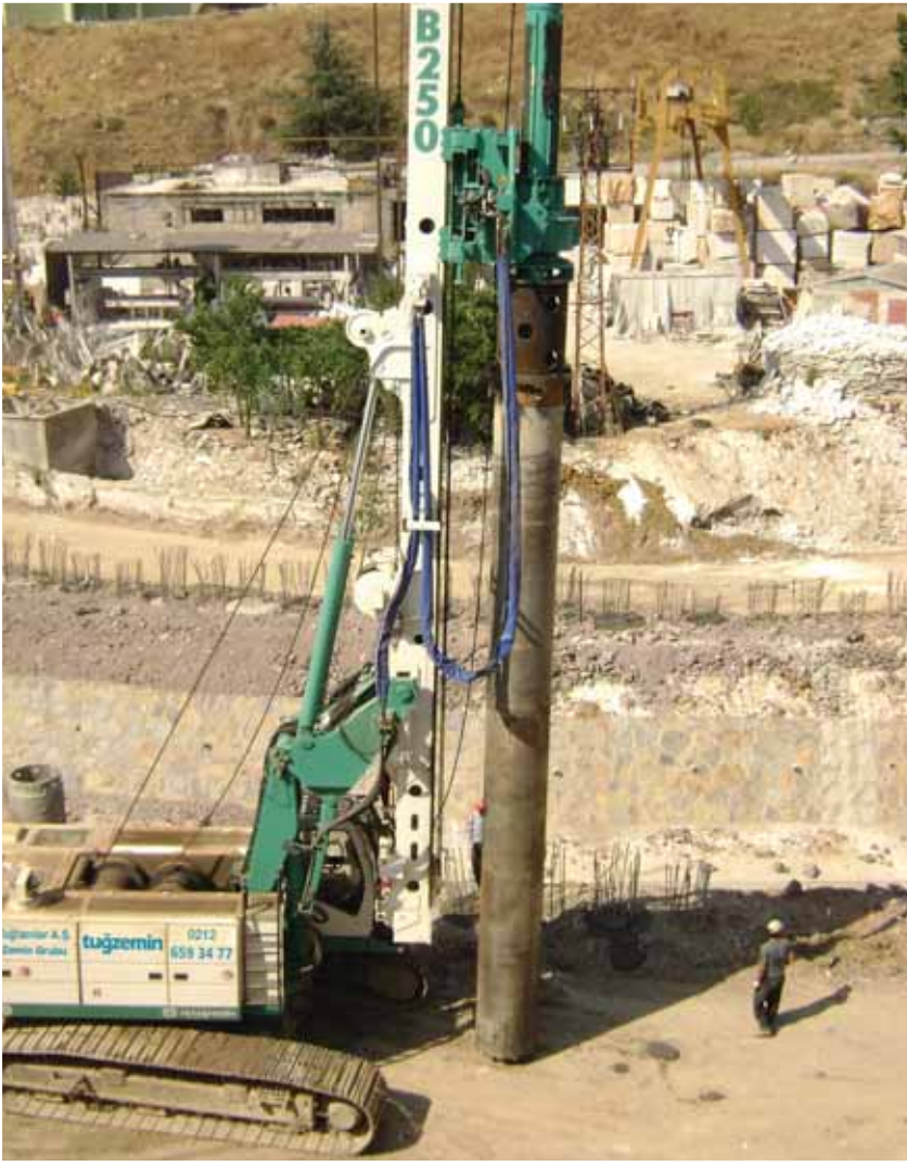
Pendik Aydos Dere Islahı ve TOKİ Konutları Bağlantı Yolu
