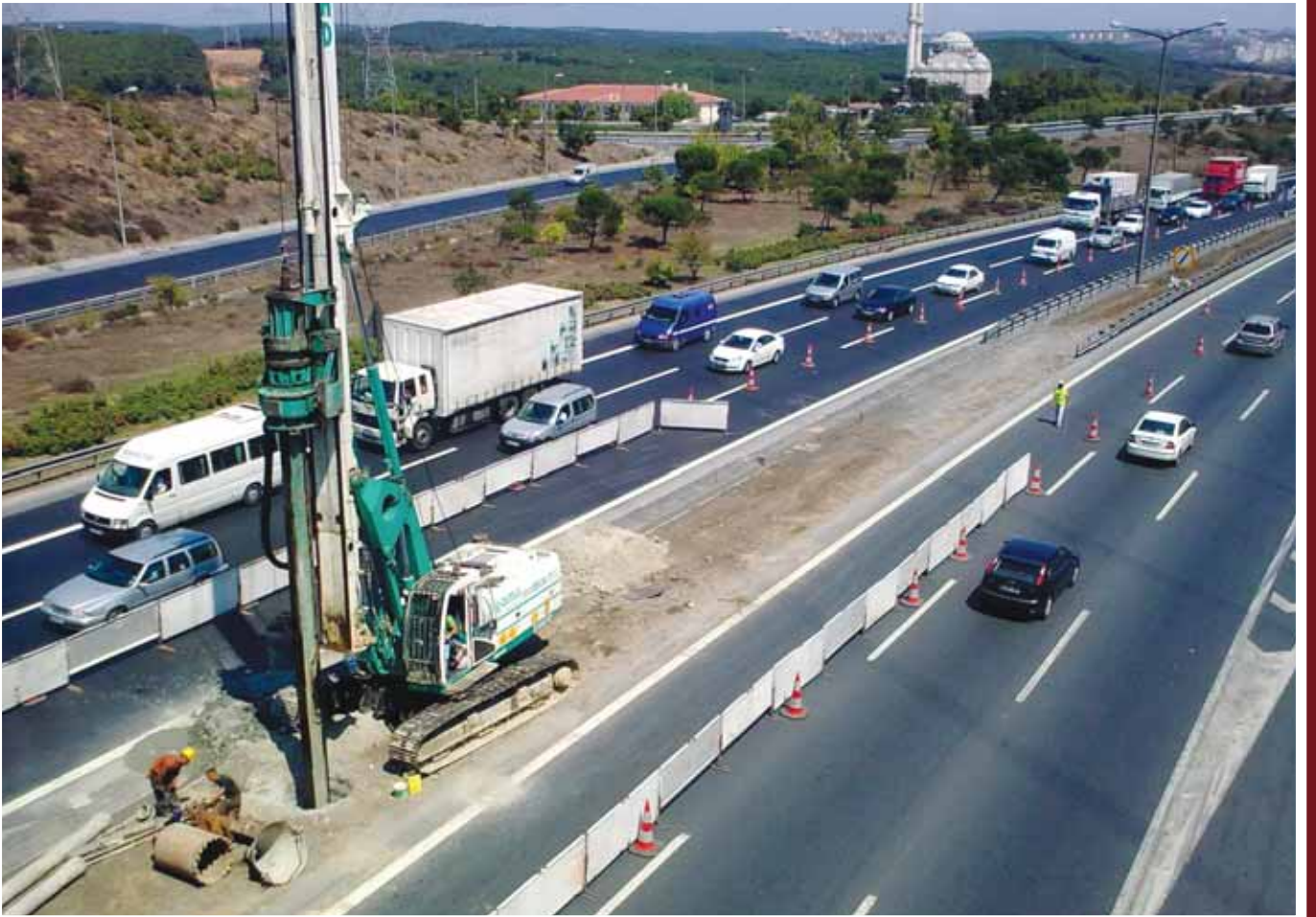
Kemberburgaz Kavşağı Üstgeçit Ayağı
